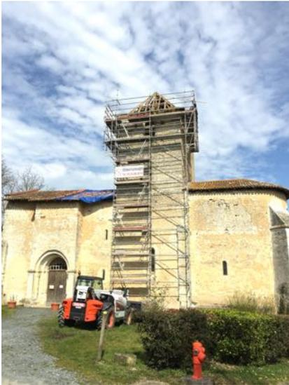
Rappelons-nous que dans la nuit du 8 au 9 septembre 2014, la foudre s'est abattue sur notre église lors d'un violent orage, occasionnant des dégâts importants sur la toiture, la charpente, l'installation électrique, détruisant complètement le dispositif son et lumière.
