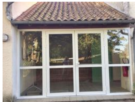
Les 2 panneaux ainsi que les 2 battants remplacés par des éléments en PVC avec vitres sécurité anti-effraction
